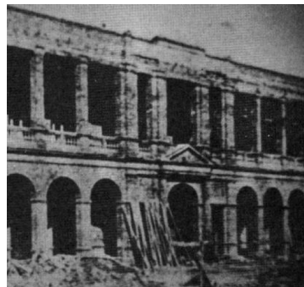
Construcción de la Casa Central de la Universidad Católica entre 1910 y 1914.
